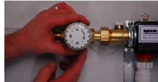
Schritt 11: Thermostatkopf in 50°C-Stellung anbringen
