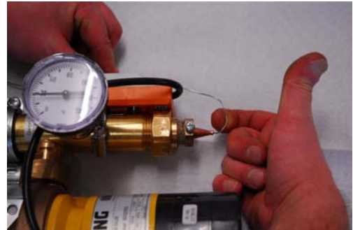
Schritt 13: ...ohne das Röhrchen am Übergang zum Fühler zu knicken (spannungsfreie Montage)
