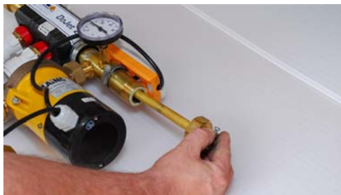
Schritt 4: Alte Tauchhülse komplett mit Überwurf entfernen
