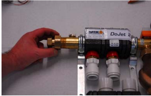
Schritt 8: Neue Flanschmuffe mit Dichtung montieren
