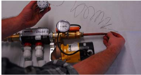
Schritt 10: Fühler in Tauchhülle einführen. Dabei Fühlerröhrchen nicht knicken.
