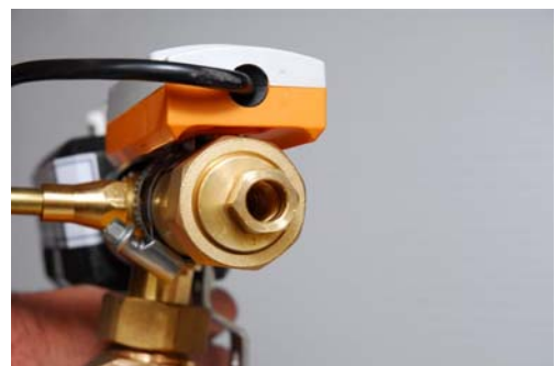
Schritt 7: Tauchhülsenöffnung nach hinten drehen und Überwurf festziehen
